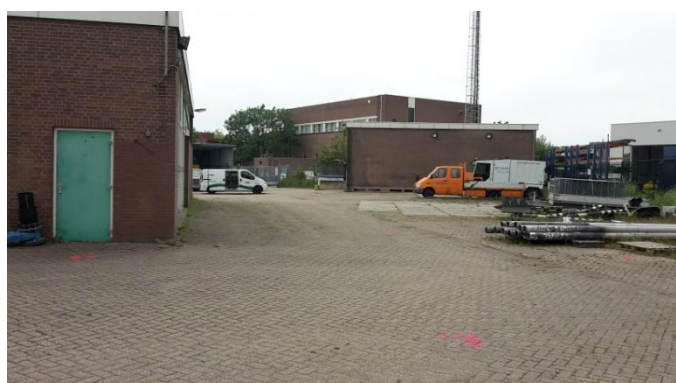
Nader onderzoekslocatie (PCB) kijkend naar het zuidwesten
